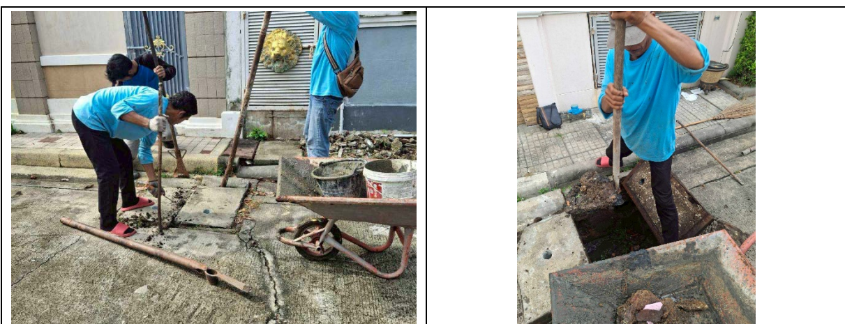
การขุดลอกท่อระบายน้ำและกำจัดขยะบริเวณตะแกรงดักขยะ
